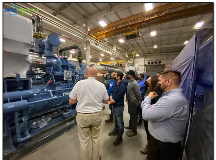
Panorámica del Recorrido de la Planta de Grupo TECSIR
